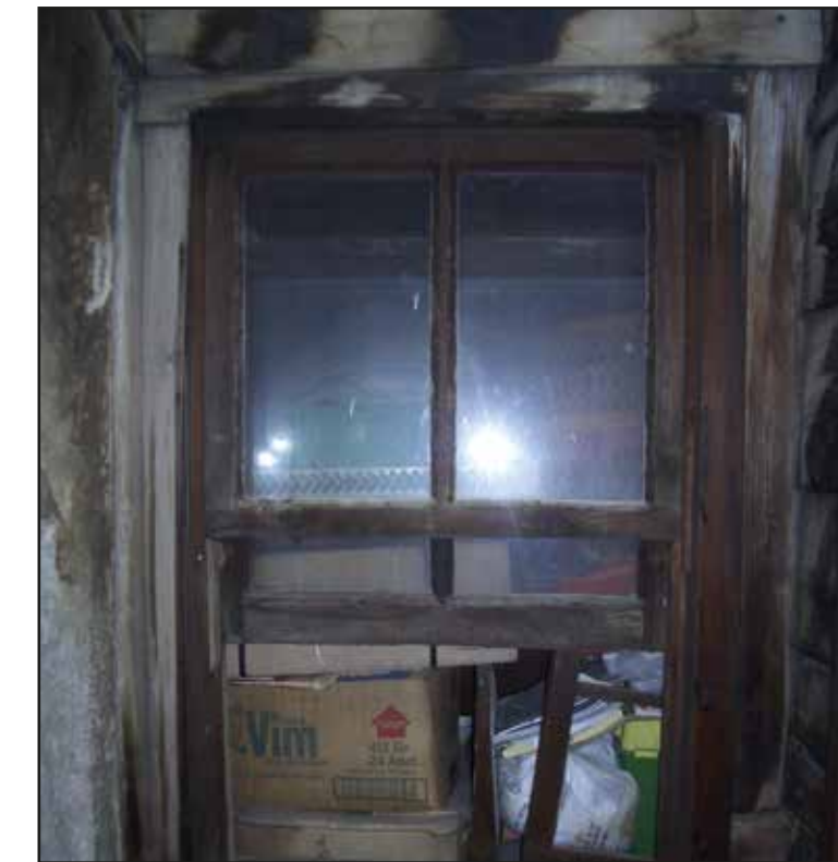
Havalandırmaya açılan pencereler
