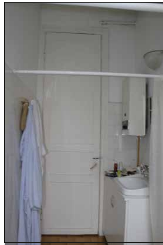
Mekanın genel görünüşü
