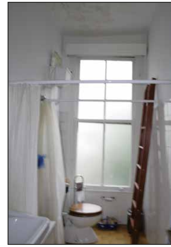
Mekanın genel görünüşü
