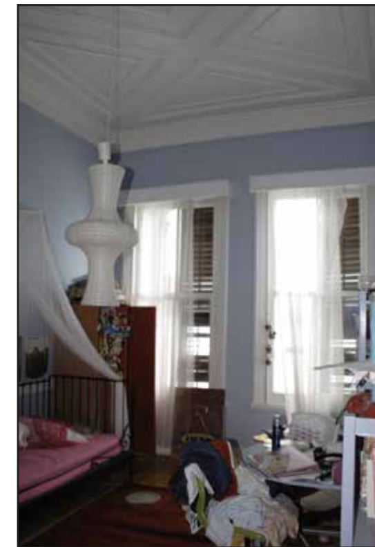
Mekanın genel görünüşü
