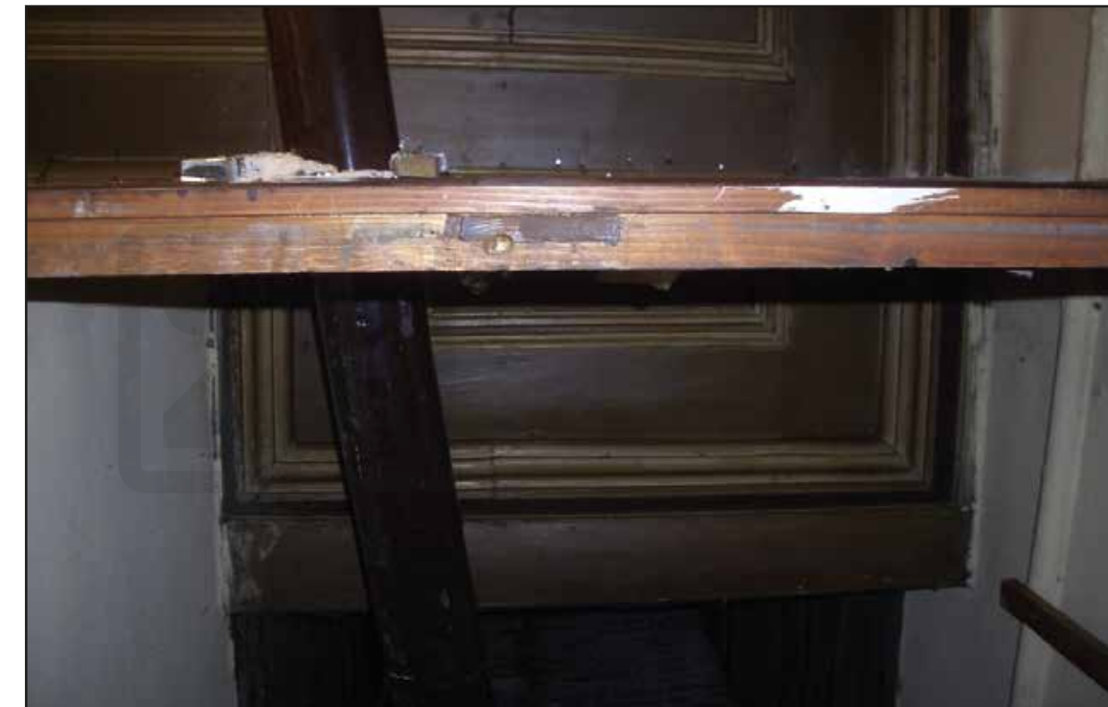
G06 ve G08 arasındaki tavanı bölen ahşap panel
