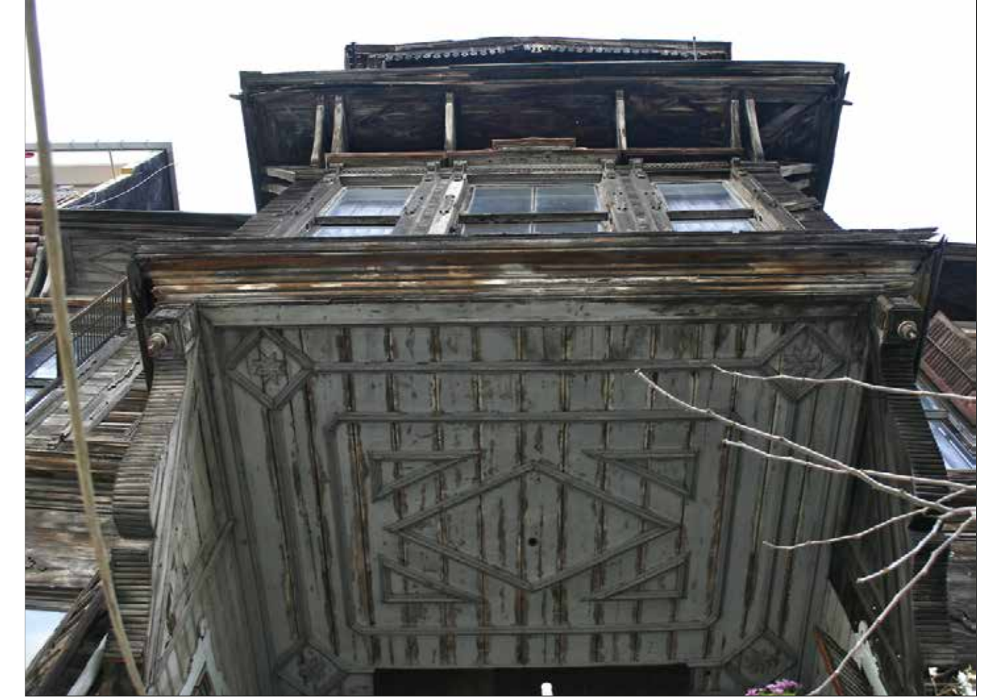
Cumba altı görünüşü
