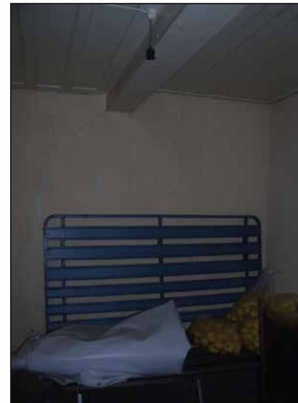
Z03 nolu odanın genel görünüşü
