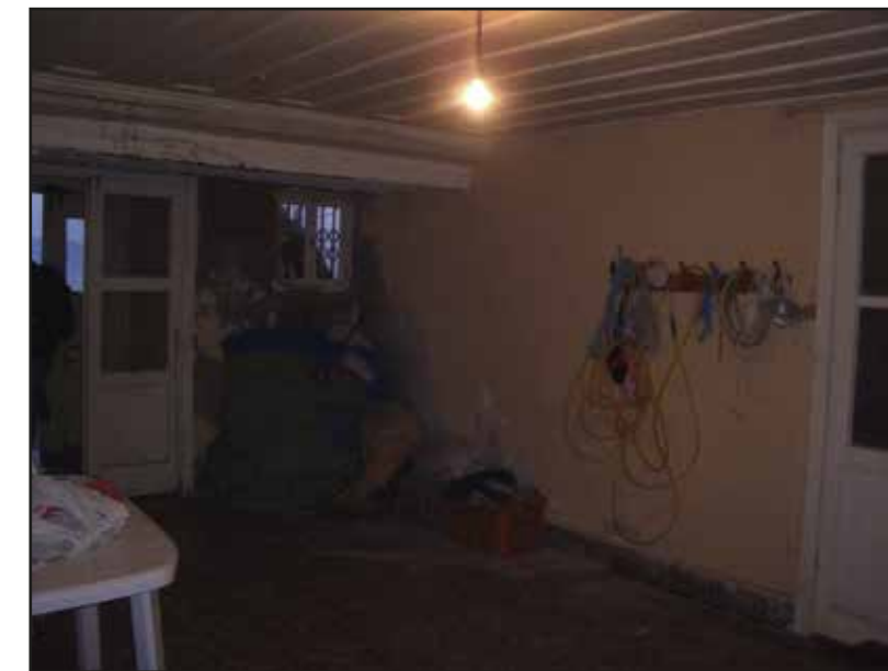
Z02 nolu odanın genel görünüşü
