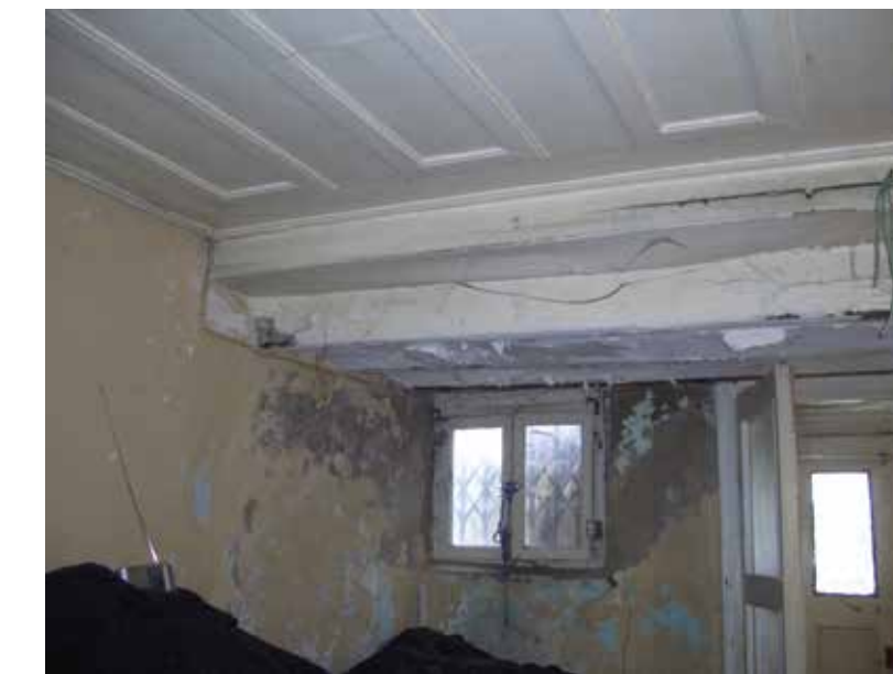
Z02 tavanındaki volta döşeme ve ahşap kaplama
