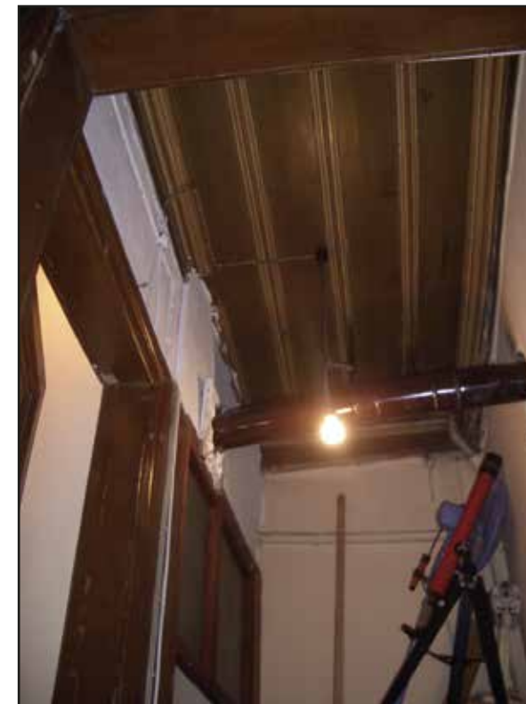
Mekanın Genel Görünüşü
