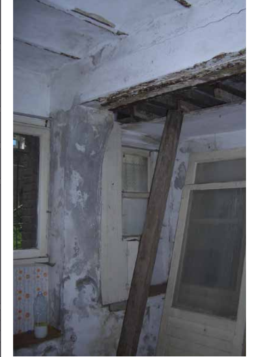
Mekanındaki volta döşeme ve sabit pencere
