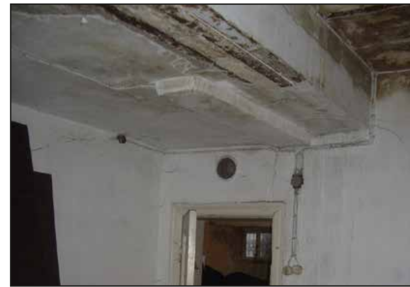
Tavanındaki düşük döşeme ve volta döşemenin birleşimi
