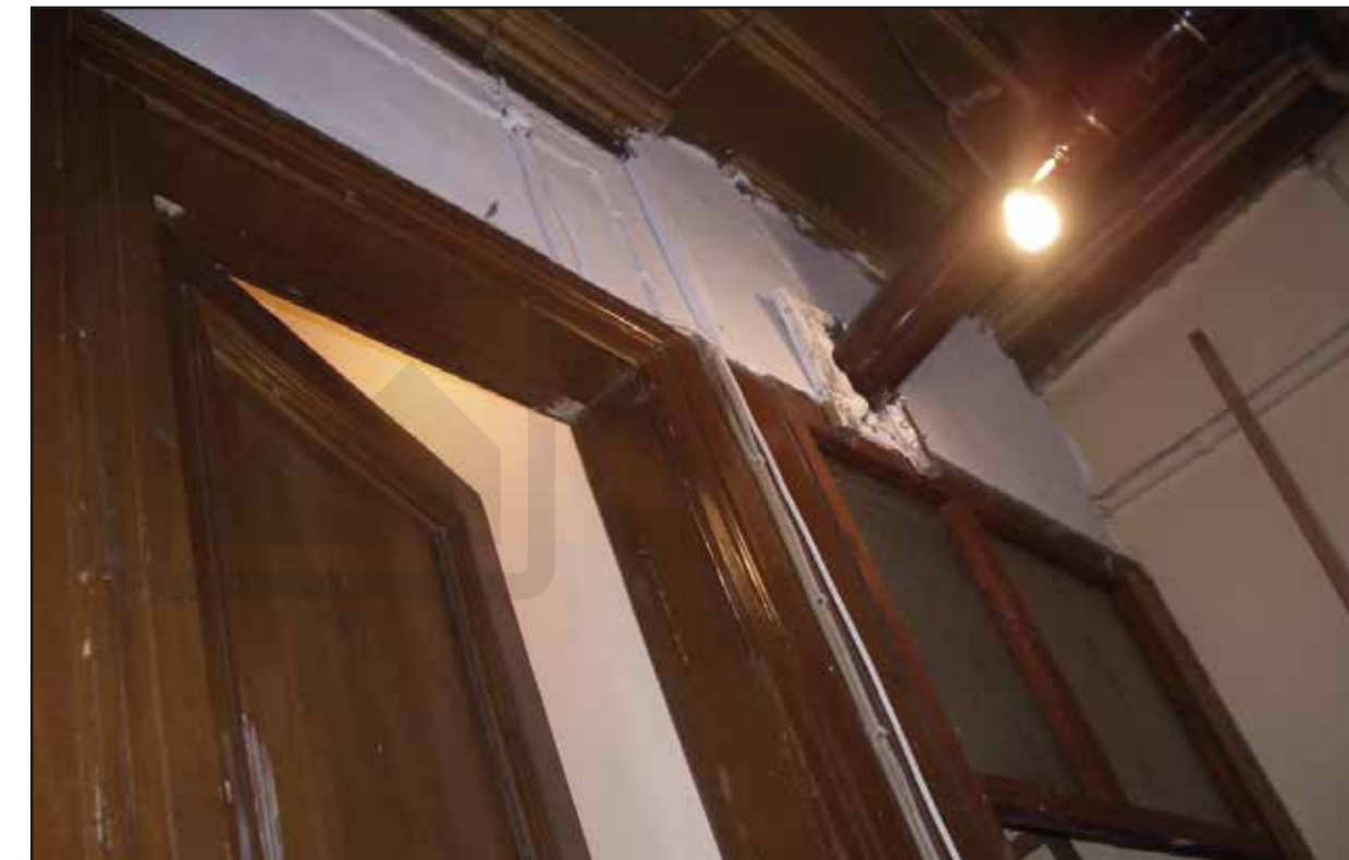
G05 ve G06 kapılarının görünüşü
