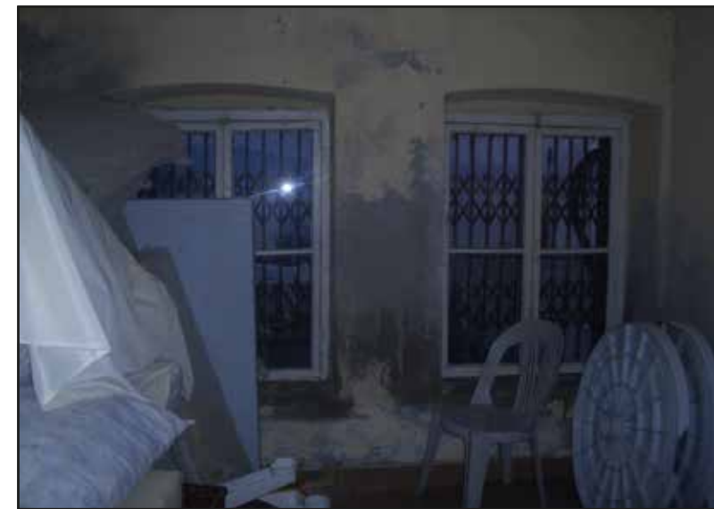
Z03 nolu odanın genel görünüşü
