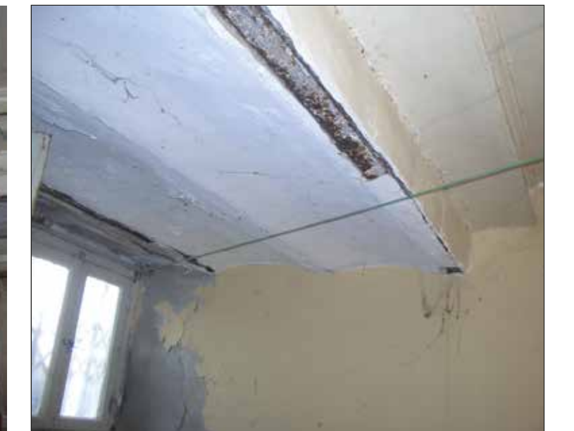
Z02 tavanındaki volta döşeme
