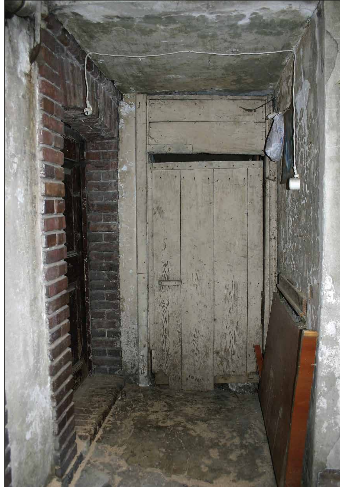
Merdiven altı deposu ve bodrum giriş kapısı
