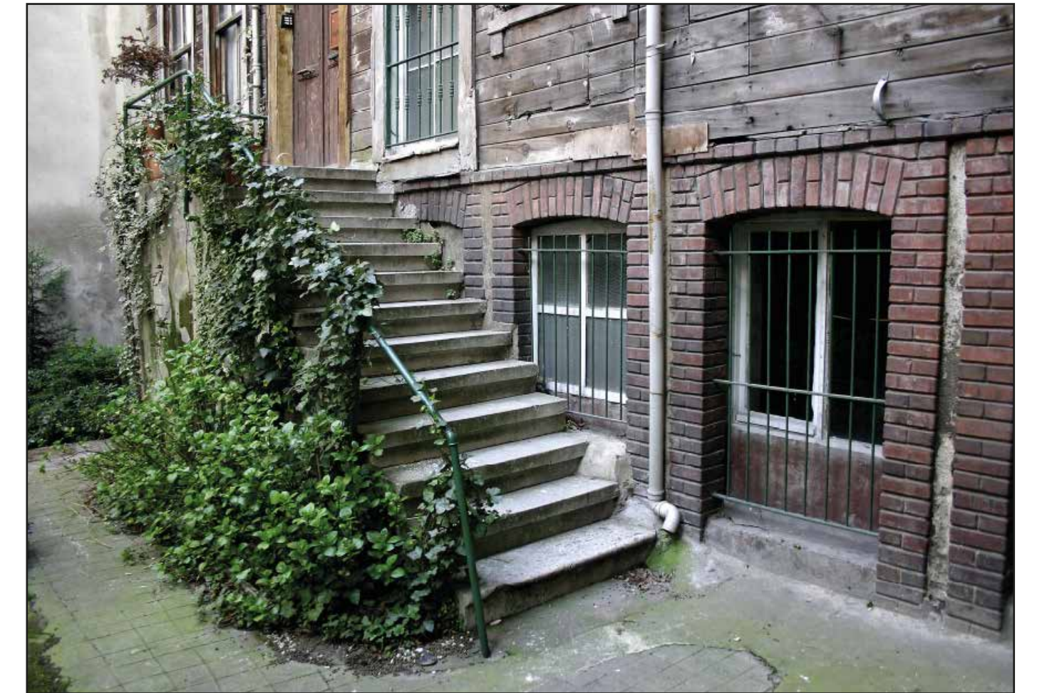
Giriş katına çıkan betonarme merdivenler
